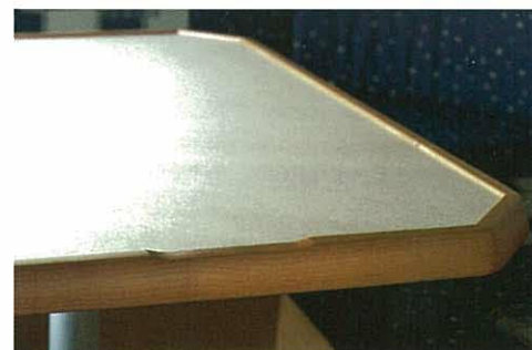
Ein kleines, aber wichtiges Detail: Die Aussparung in der Tischkante erleichtert die Reinigung der Oberfläche von Krümeln.
